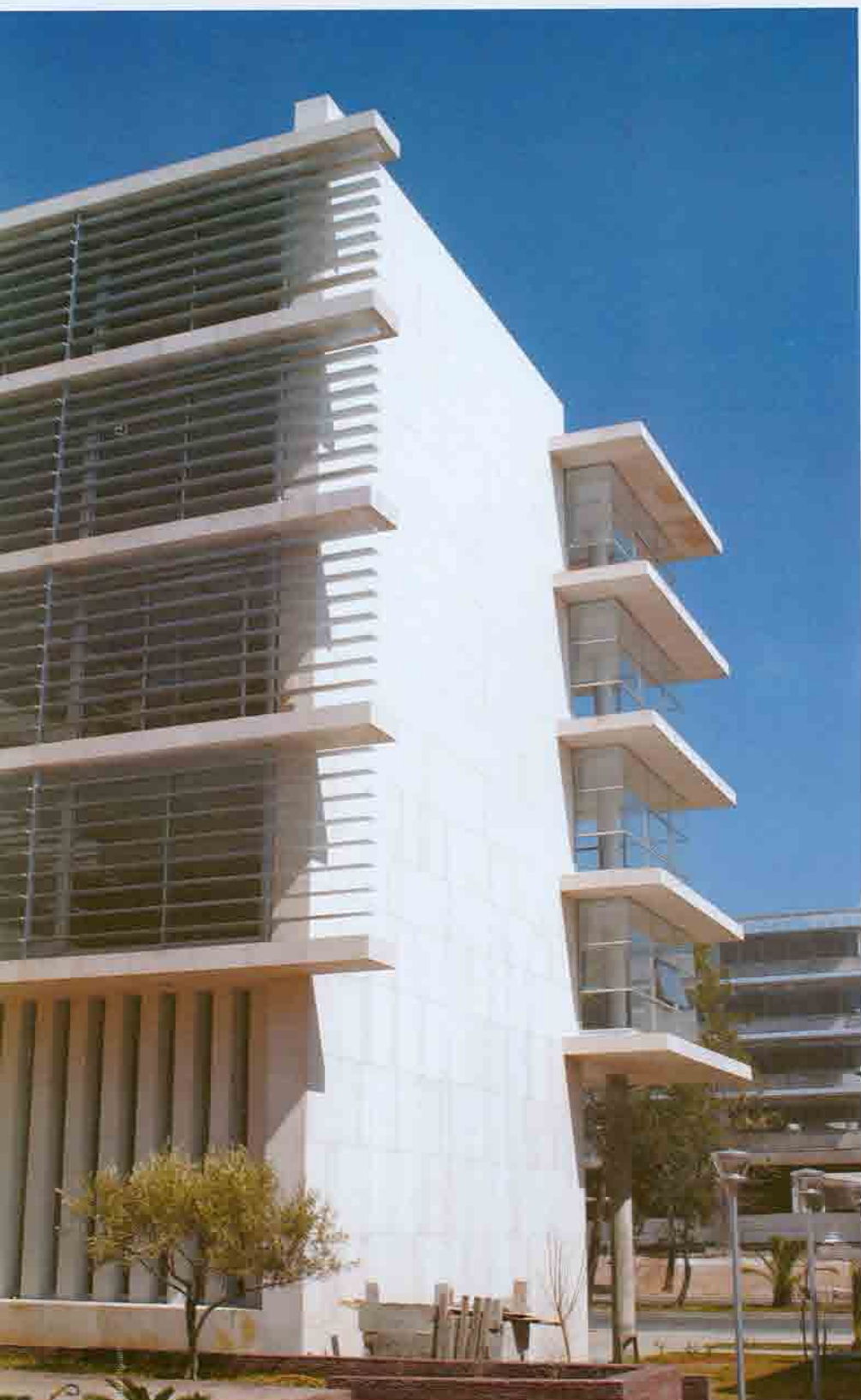
Chaque façade s'exprime différemment selon son orientation. Au nord, les baies vitrées libres dominent, alors qu'au sud elles sont protégées par des brise-soleil orientés qui se détachent du plan vertical
