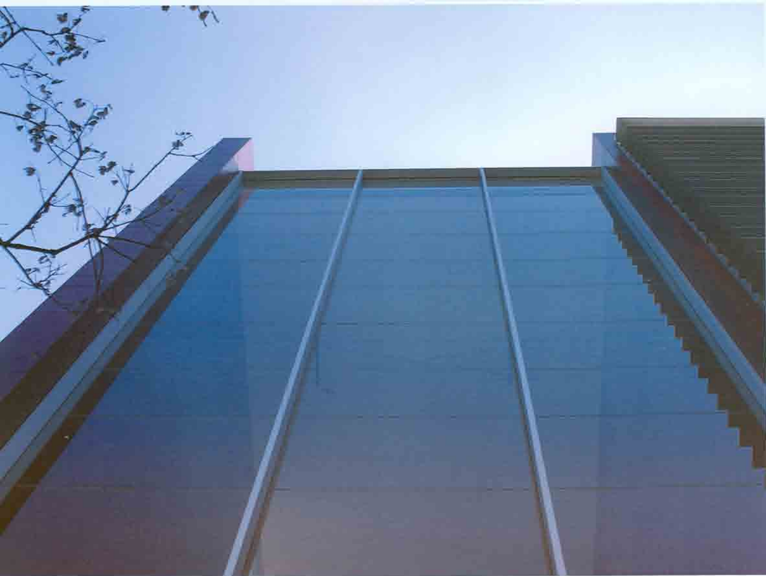
L'huisserie est totalement encastrée dans la dalle afin d'effacer la présence des profilés métalliques
